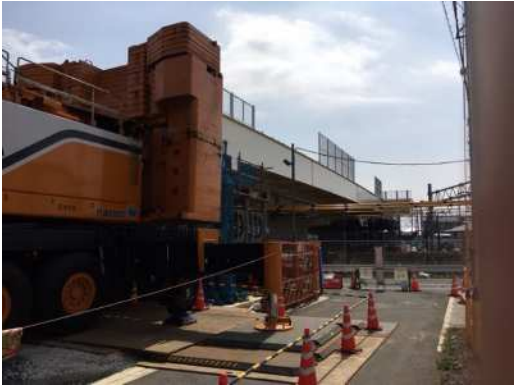
名都借跨線橋の道路拡幅改良
