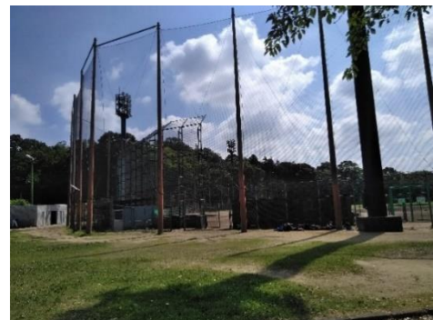
改修工事を行う予定の総合運動公園野球場
