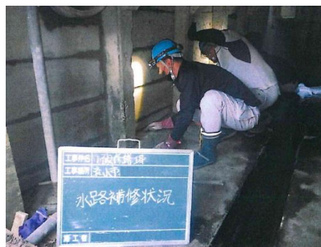
排水路の補修工事の様子
