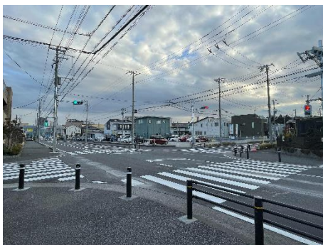
交通の安全を確保するために設置したボールや防護柵
