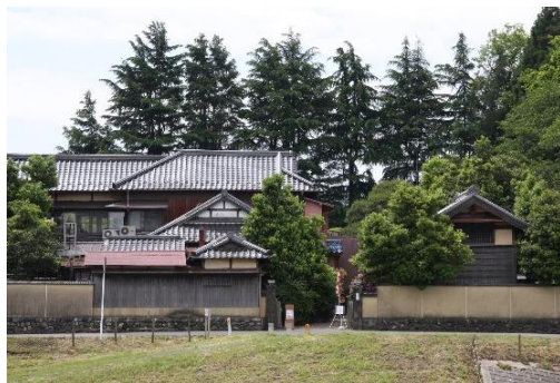
観光・地域交流センターに改修予定の旧割烹新川屋本館
