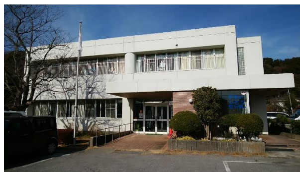
屋上防水工事、外壁改修工事を行う予定の 思井福祉会館
