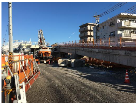
道路拡幅改良工事中の名都借跨線橋
