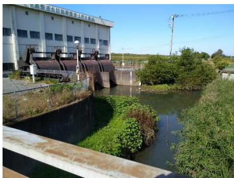
改修を行う予定の流山排水機場
