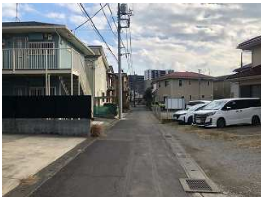
令和 6 年度に排水整備工事を予定している箇所
