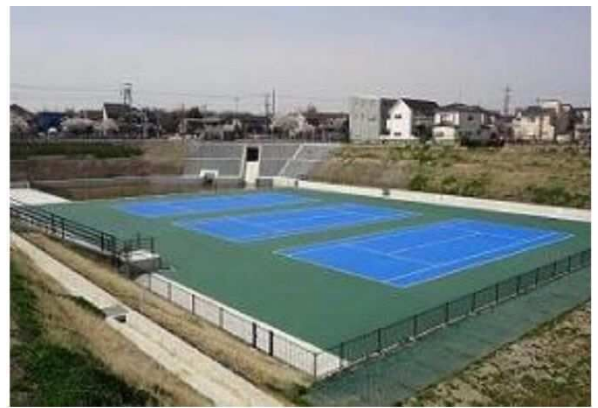
図 3-2-3 大雨時と平常時の新東谷調整池
